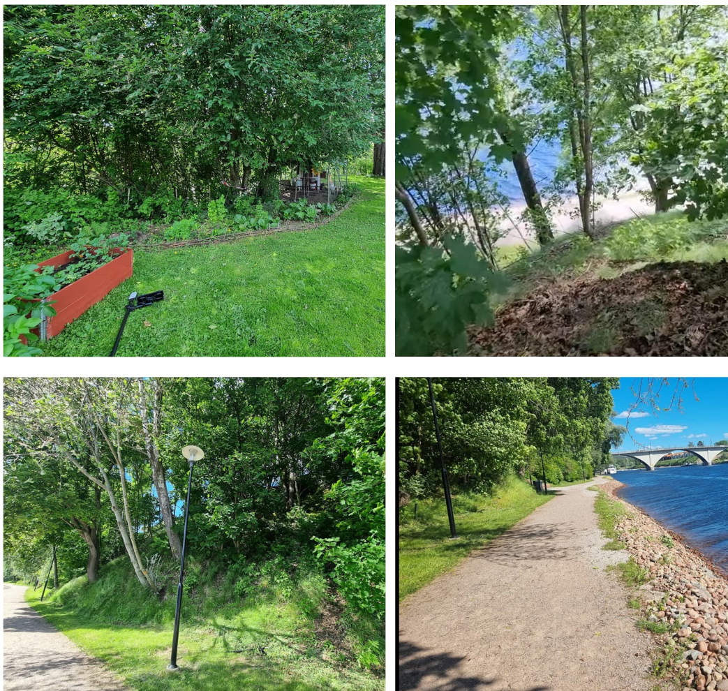
Figur 7.3 Foton från platsbesök. Uppe till vänster foto på trädgård ovan släntkrön, uppe till höger slänten ovanifrån. Nere till vänster släntfot. Nere till höger strandpromenaden
