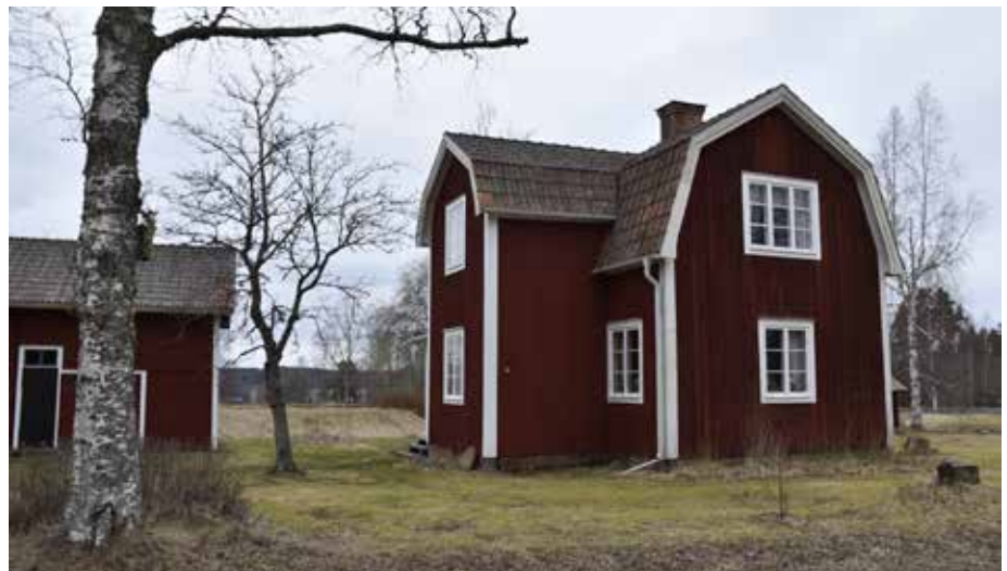
Vissa av de småhus som uppfördes under det tidiga 1900-talet har mansardtak, ett stildrag sannolikt hämtat från nationalromantiken. Hjortnäs 49:4.
