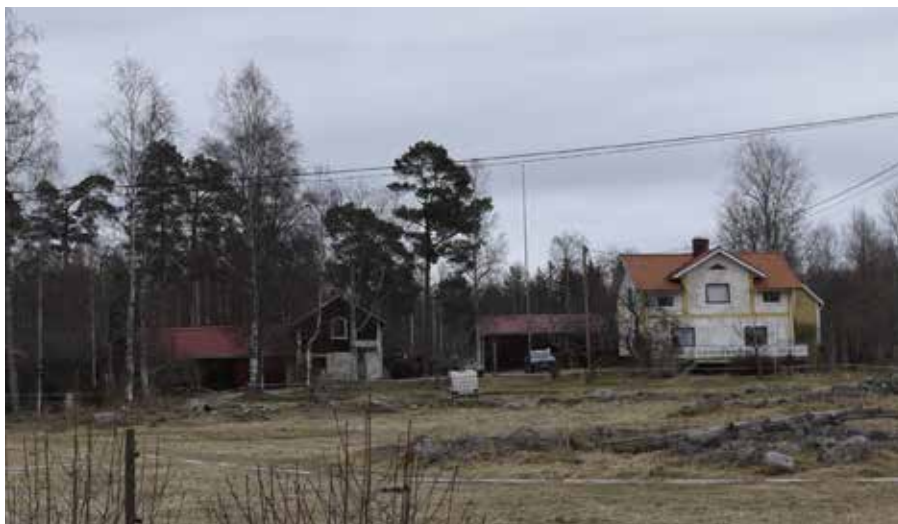
Gård med sen 1800-talskaraktär i norra Hjortnäs. Manbyggnaden är ett korsplanshus med reveterad fasad. På gården finns även ett tidstypiskt ladugårdskomplex. Hjortnäs I:12.
