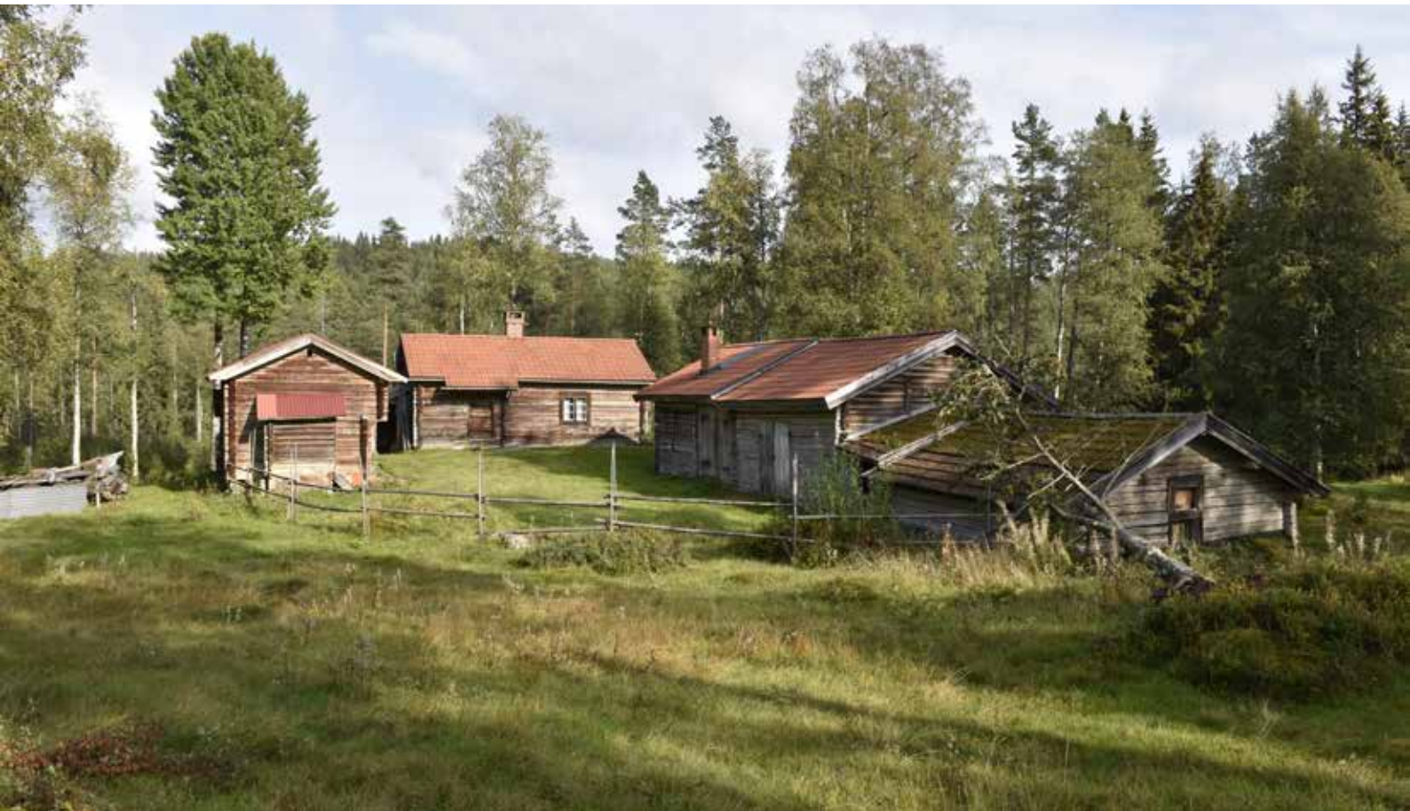
Fäbodgård med älderdomliga grånade timmerhus, däribland ett lågt fähus typiskt för Leksandsbygden i äldre tider till höger i bilden. Även fäbodstugan är älderdomlig, med förtak och bräddörr. Västanvik 51:16.
