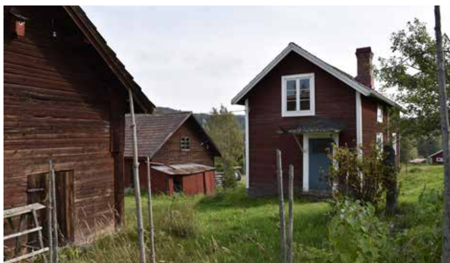
Kringbyggt gårdstun i sluttningsläge. Ytterdörrarna på gården har utbytts mot nya i karosseripanel kring 1900-talets mitt. Björkberg 17:3.
