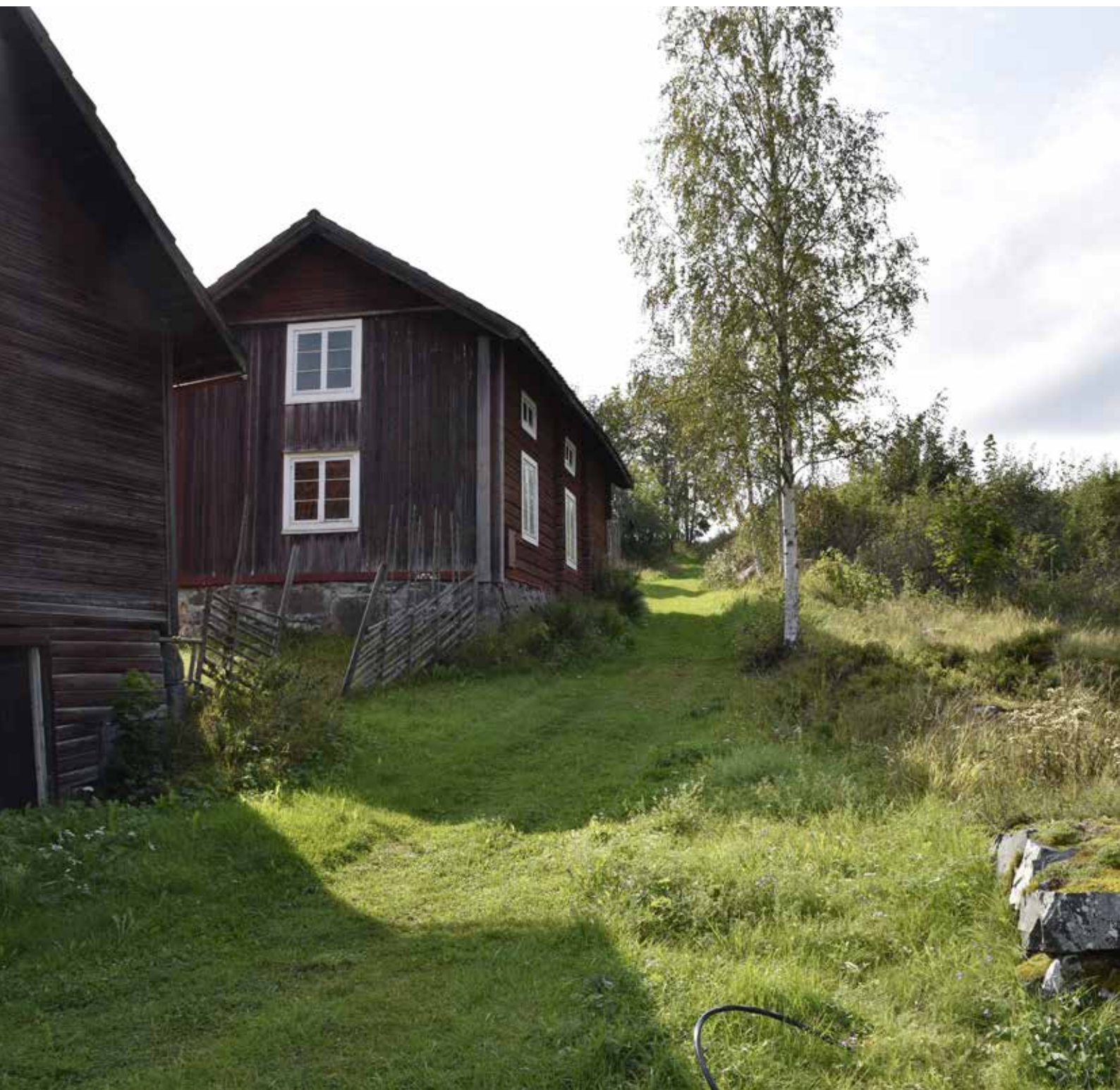
Äldre enkelstuga på gård väster om majstångsplatsen. Byggnaden är ålderdomlig och står på en naturstensmur som överbryggar nivåskillnaderna i det sluttande landskapet. Björkeberg 17:3.
