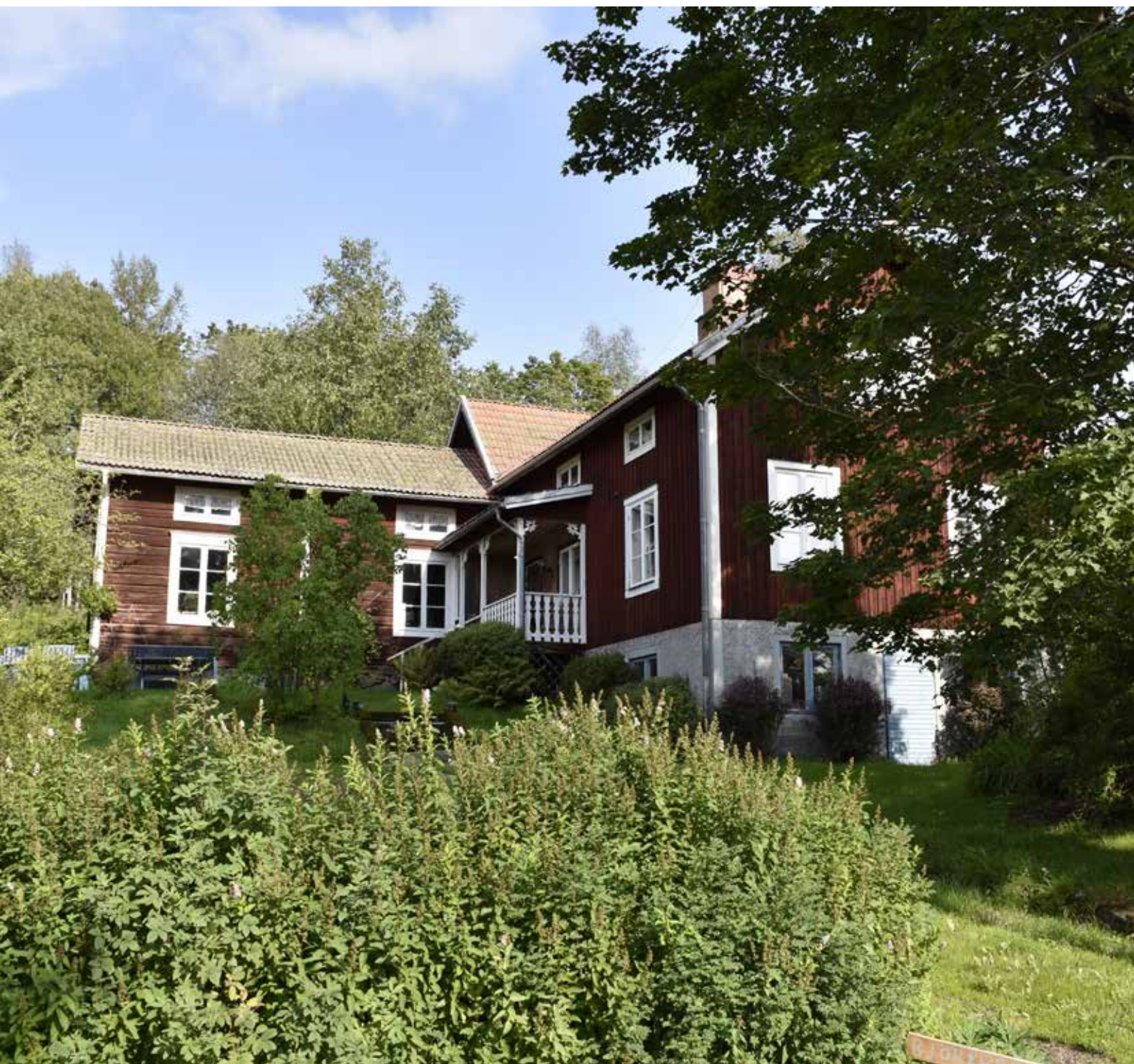
Gård med hög sockel i den södra delen av byn. Många byggnader är uppförda i sluttningslägen och har därför höga socklar. Björkberg 8:5.
