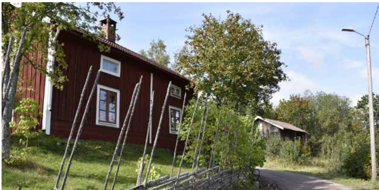
Äldre enkelstuga med kilsågad locklistpanel i den norra delen av byn. Fönstren är dock bytta i senare tid. Björkberg 2:6.
